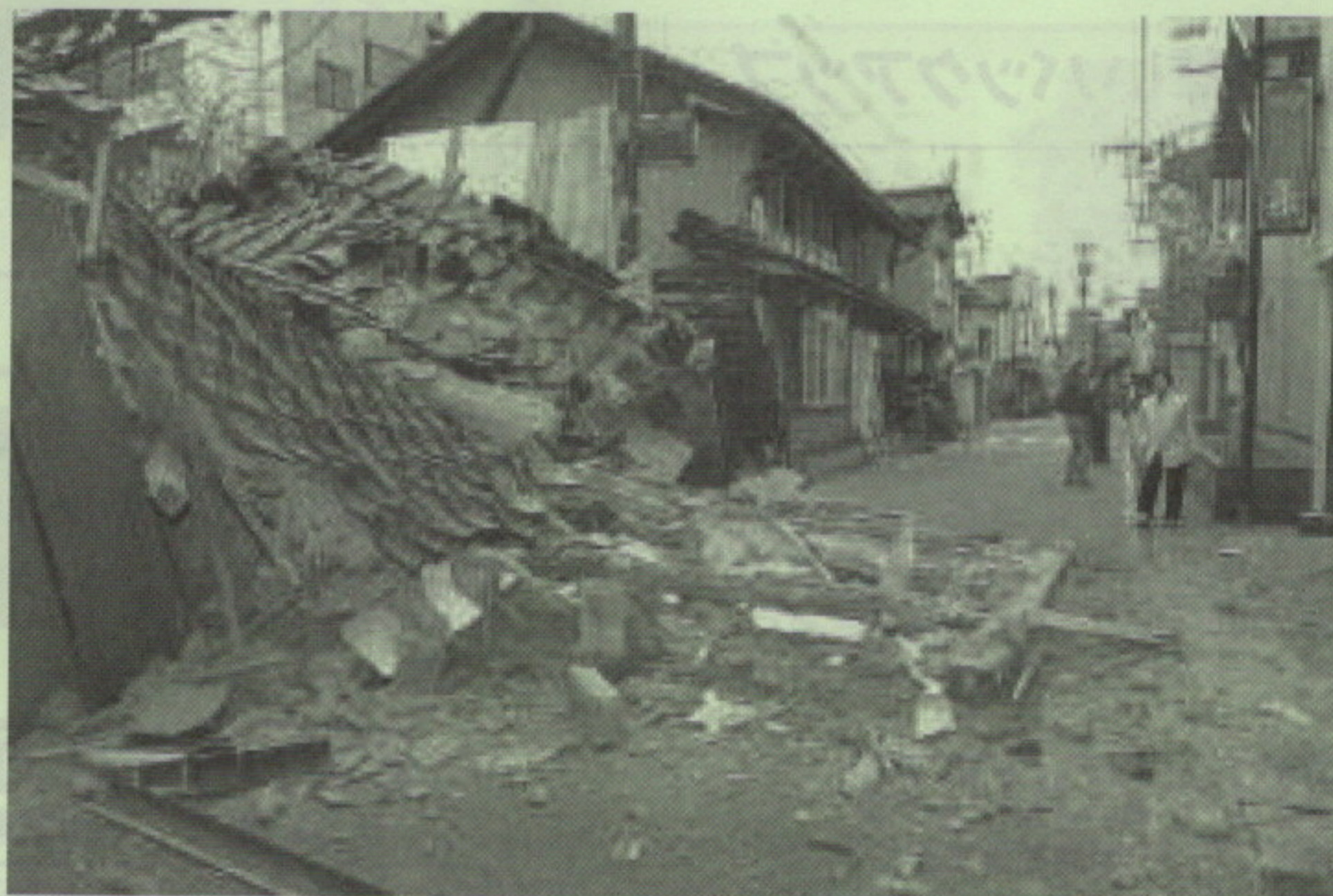
平成 19 年 能登半島地震による被害
